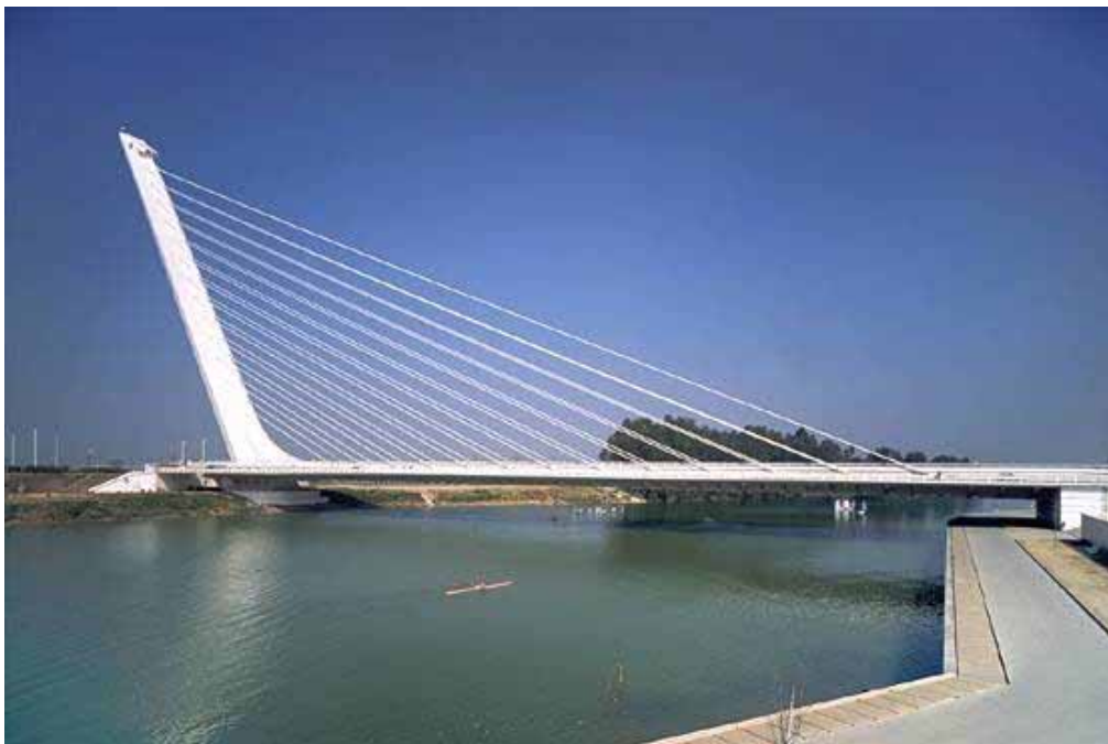
Slika 9: Calatrava, Santiago (1992): Most Alamillo, Sevilla, Španija. 108
